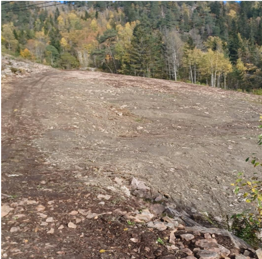
(Planeringsarbeid i øvre del av bakken.)
